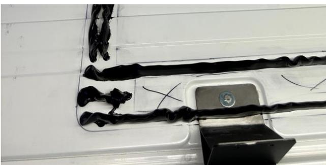
Abb. 2-6: Klebstoff Auftrag auf dem Dach
