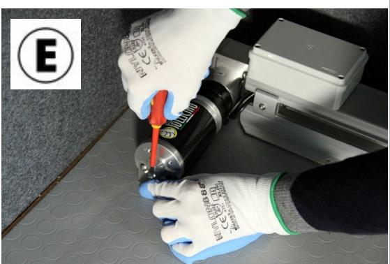
Bloccare il MOTORE con vite autofilettante. In alcune tipologie di pavimenti potrebbe essere necessario bloccare con vite e dado.
