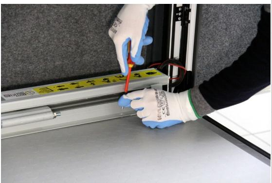
Bloccare la GUIDA con viti autofilettanti. In alcune tipologie di pavimenti potrebbe essere necessario bloccare con viti e dadi
