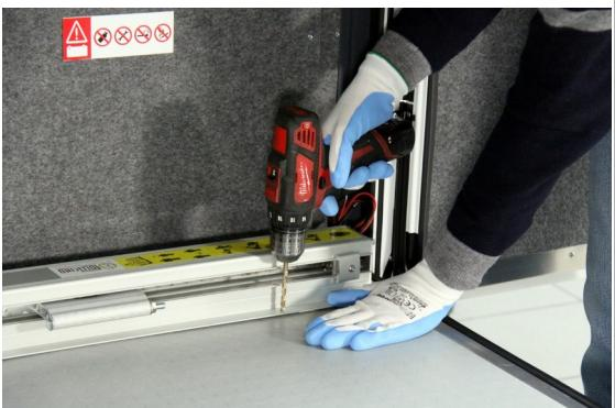
In caso di rivestimento del pavimento molto duro, eseguire foratura dei punti di fissaggio
