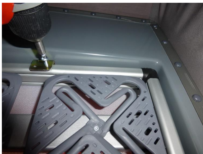
36. Scharniere am Bettgestell festschrauben Mount hinges on the bed-frame
