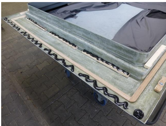
17. Nach Reinigung: Sikaflex® 522 Auftrag auf GFK-Rahmen hinten After cleaning: application of Sikaflex® 522 on GRP-frame rear area
