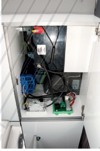
Bild 14: Zweitbatterie und 230 V Elektrik im Schrank hinten rechts
