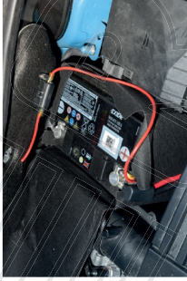
Bild 15: Stromanschluss am Pluspol der Fahrzeugbatterie im Motorraum
