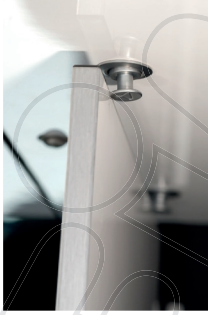
Bild 12: Ungenügende Auflage der Schlafbank auf den Knöpfen am Schrank rechts
