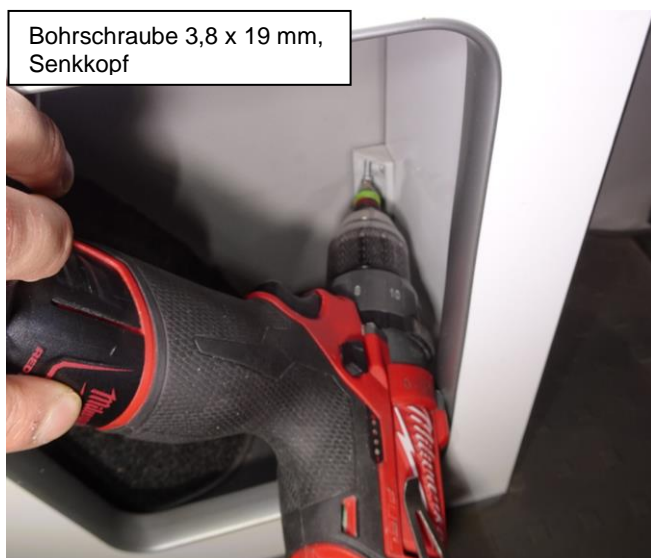
Korpus in korrekter Position, Schraubpositionen
